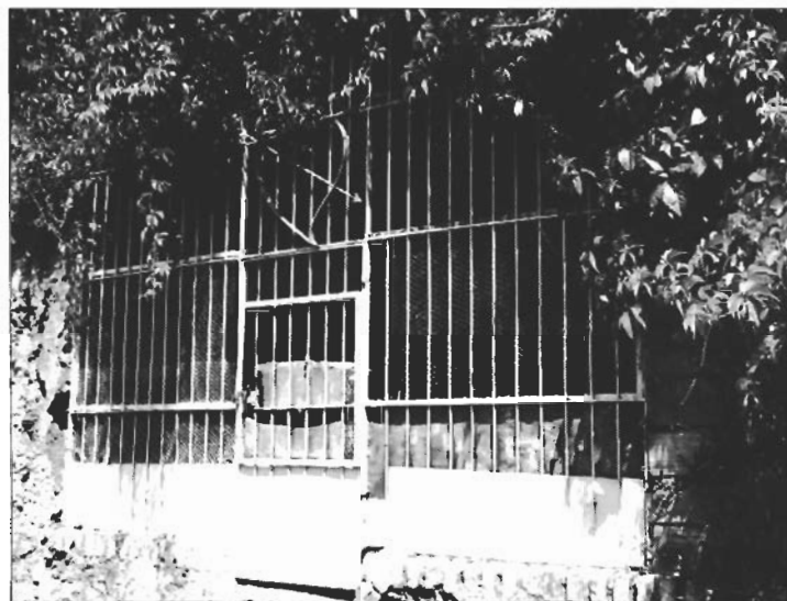
La cappellina in Via degli Olmi, dentro uno dei fornicelli dell'Acquedotto.
